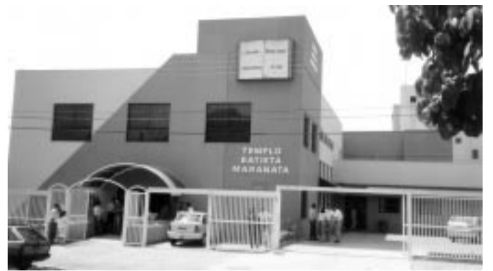
Fachada do T.B.M - Goiânia
